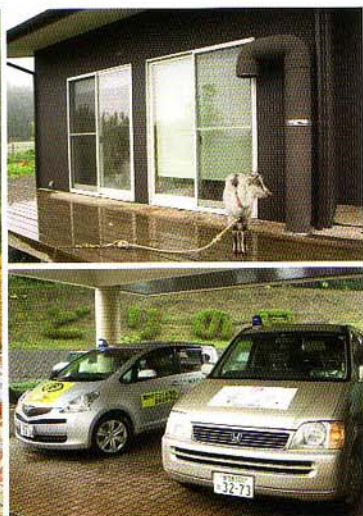
上：外気を地下に送るパイプ 下：青色回転灯を装備した送迎車
